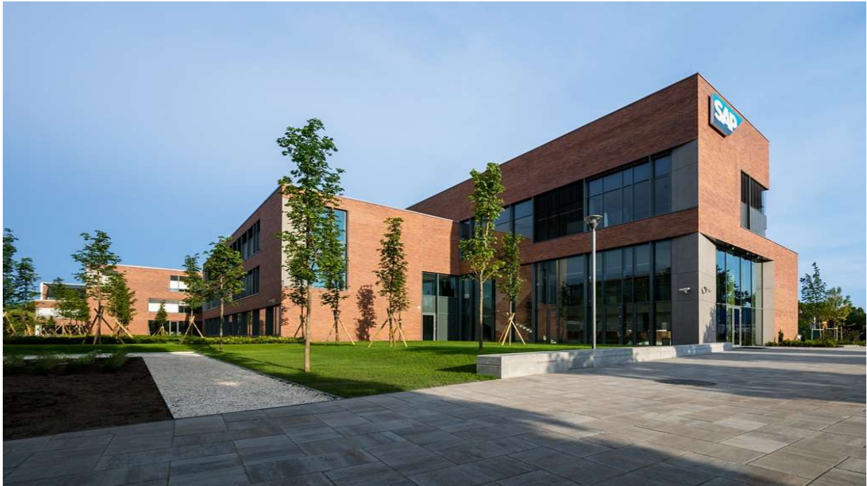
SAP new wing (Architect: Vikár és Lukács Építész Stúdió)
