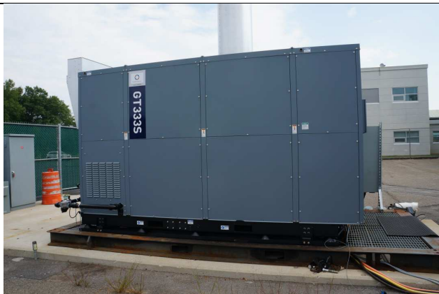
GT 333 Turbinás egység 333 kW teljesítménnyel
